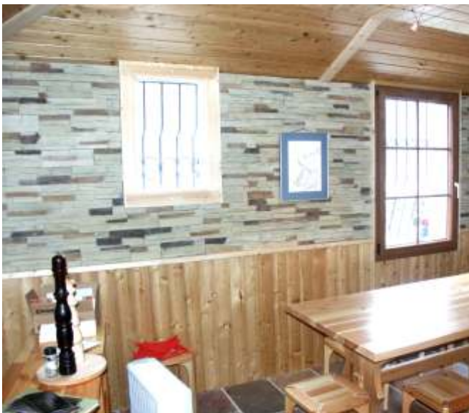
Pose des plaquette de bas en haut. Les longueurs des plaquettes sont panachées par carton
